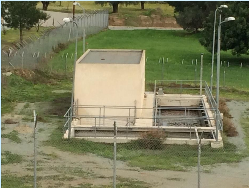
Σταθμός Επεξεργασίας Λυμάτων
